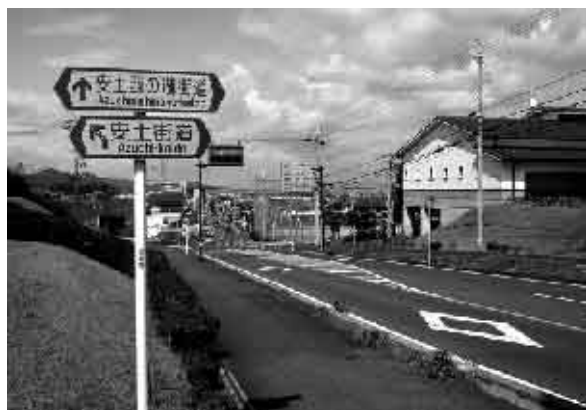
道路通称名・案内標識設置
